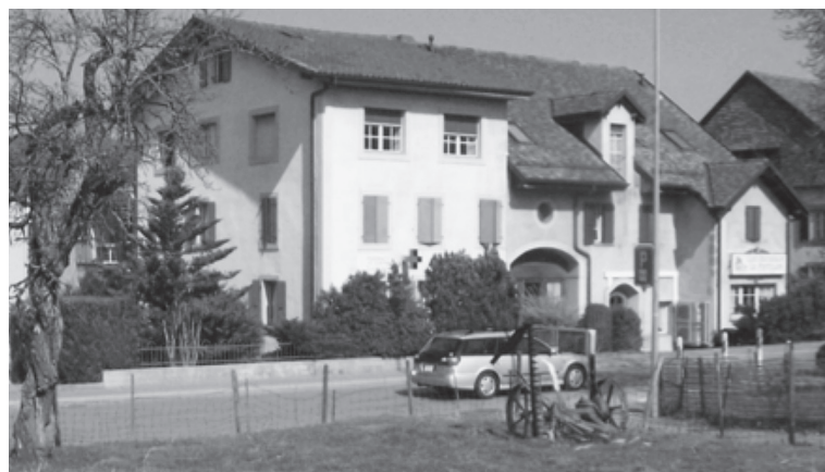
Le bâtiment aujourd'hui
