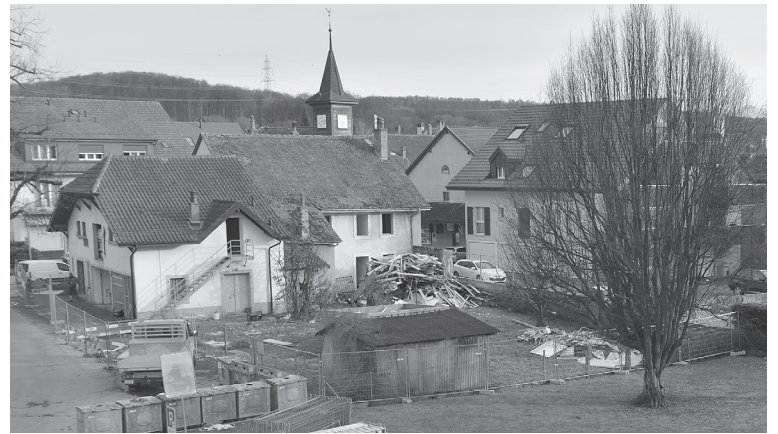
Le 31 janvier 2013, l'immeuble 4 jours avant sa démolition
