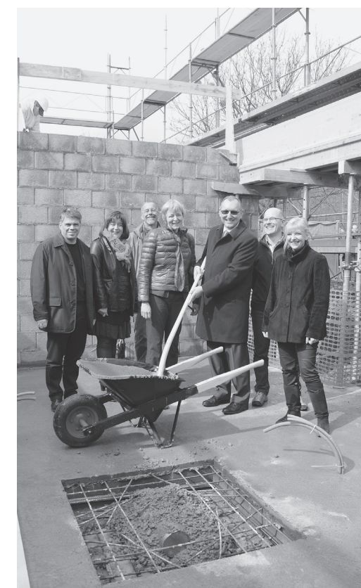
Les membres de la commission de construction d'Une Maison pour nos Aînés. De gauche à droite, Graeme Mann, architecte du projet, Maria Mauron, directrice du secteur Administration et Finances de la Fondation, Richard Burnier, éducateur social, Mireille Scholder, directrice de la Fondation, Vincent Vouillamoz, architecte conseil APHAGI et Patricia Capua Mann, architecte du projet
