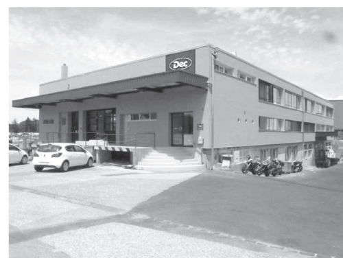
Le nouveau bâtiment de Cheseaux
