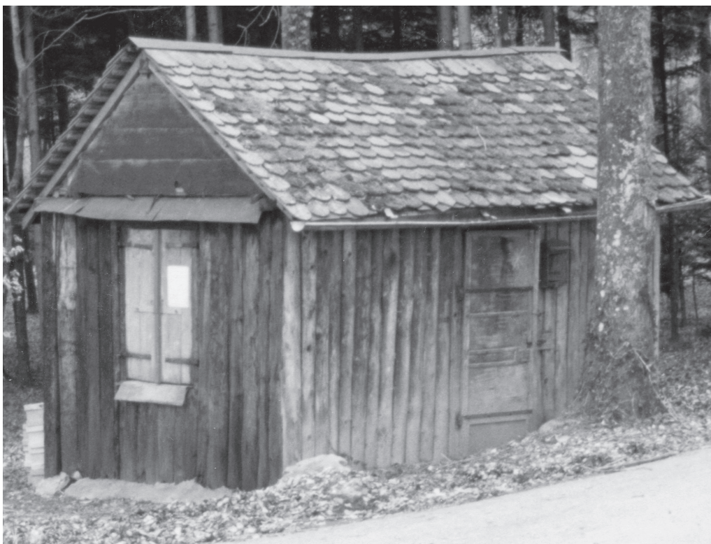
Le «château» de Louis Dufour en 1994, juste avant sa démolition
