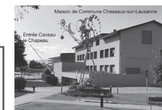
Maison de Commune Cheseaux-sur-Lausanne
