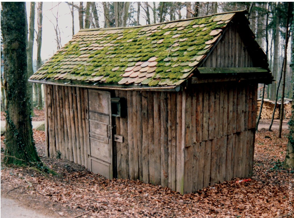
Le « château » de Louis Dufour en 1994, juste avant sa démolition
